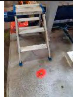
Il manque un accès à la passerelle polymère. Prévoir une petite marche escamotable pour limiter le risque de chute. Passerelle non prévue suite aux travaux de réfection de 2019
